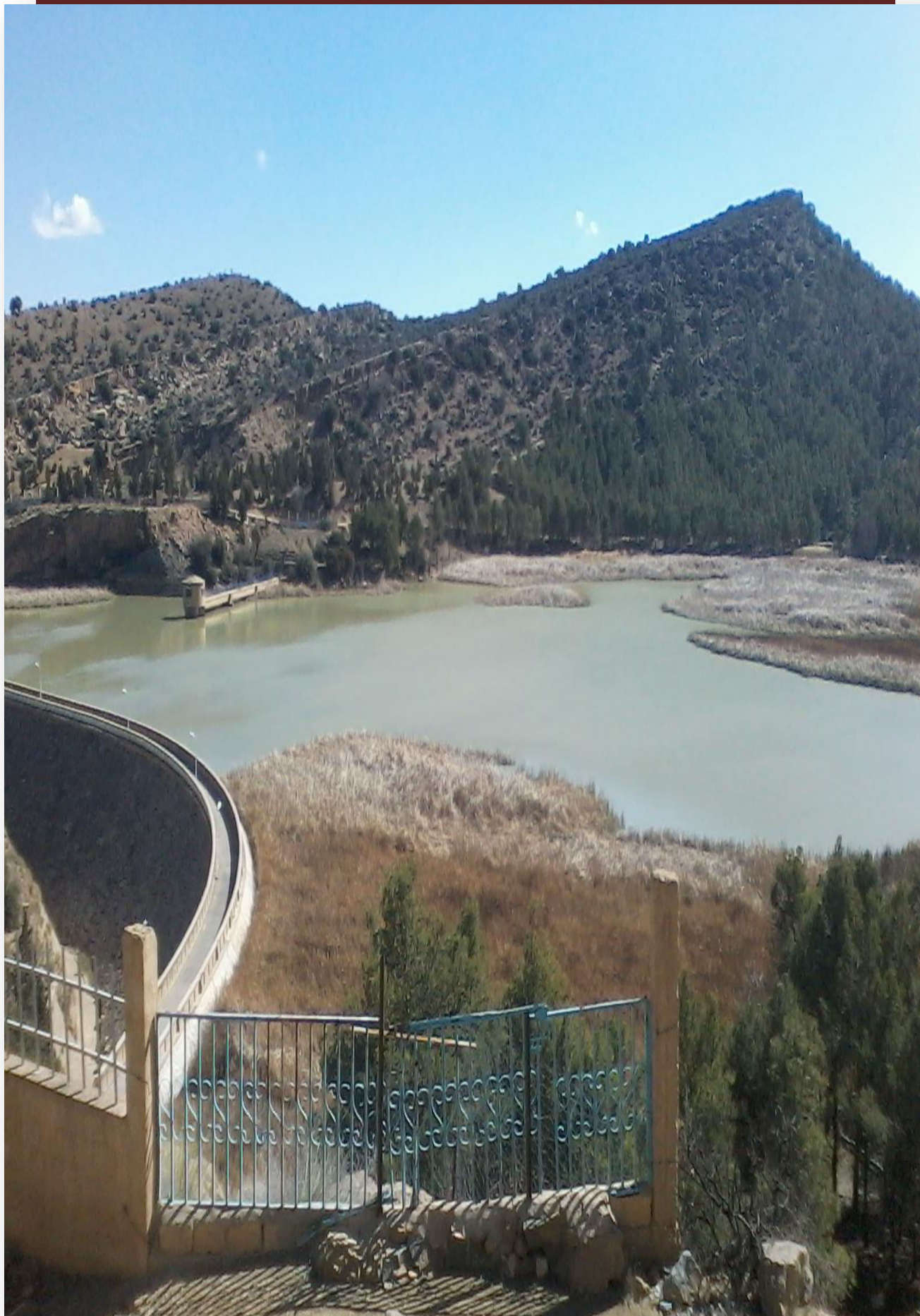
Photo n°1 : Barrage Foug el Guess (kais,Khenchela ,2017)
