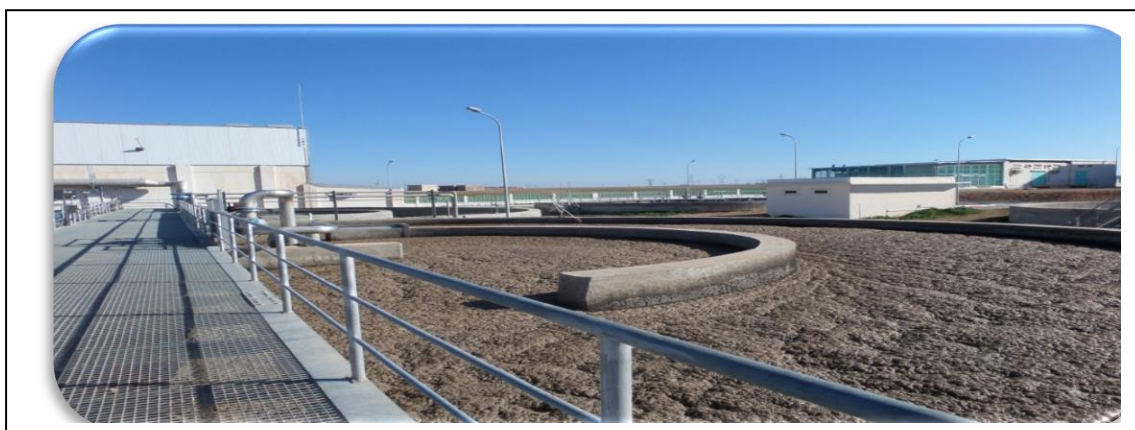
Figure 22 : Digesteur aérobie.
