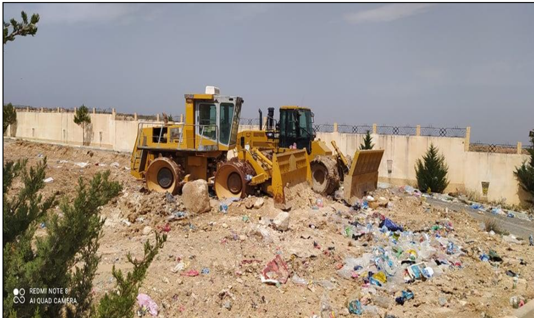
Photo 5: Bulldozer et compacteur
