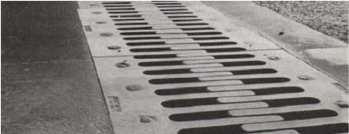
Fig.IX.4. Joint de la chaussée
