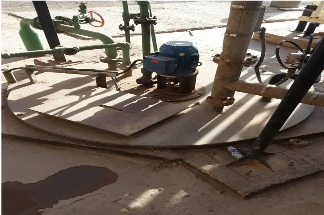
Figure.II.08 : Photo de Puisard G-504
