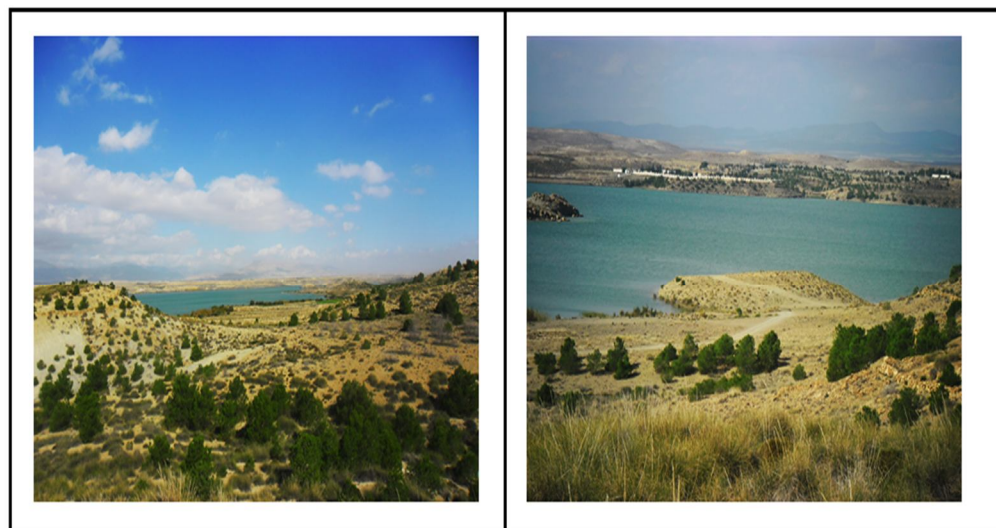
Figure 41 : Barrage de Babar (Photos personnelles, 2015)
