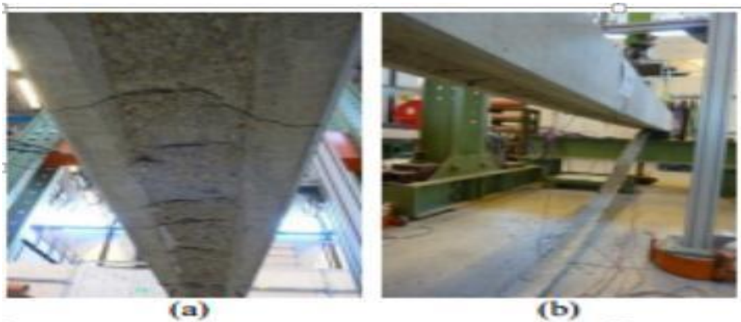
Figure 5-3 Modes de ruptures des éprouvettes (a) les fissures intermédiaires; (b) décollement du stratifié dû aux fissures intermédiaires en B2.
