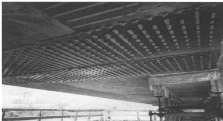
Figure 3-5 : plaques d'acier collées
