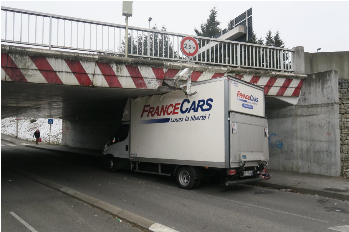
Figure 2-6: Eclatement du béton dû à un choc.
