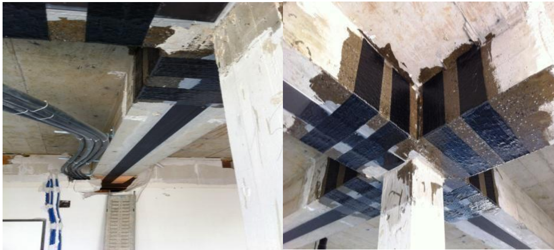
Figure 3-8 : poutres en BA renforcées par matériaux composites.
