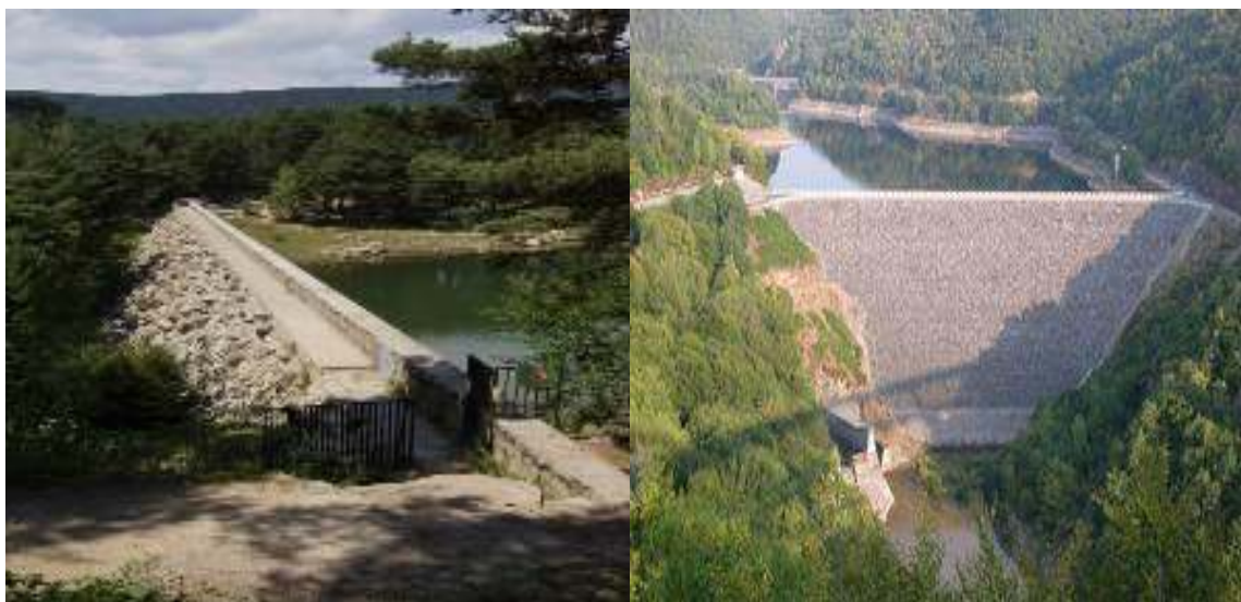
Figure 06 : Barrages en enrochements
