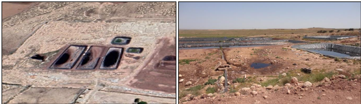
Figure III.5 : Système de lagunage
