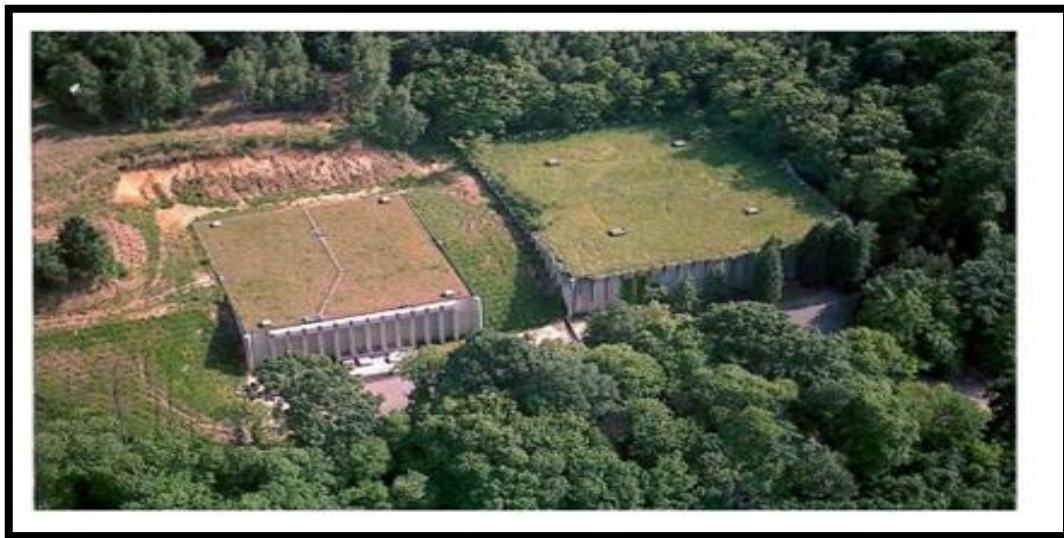
Figure I.3 : Réservoir semi-enterré rectangulaire de LINAS-France
