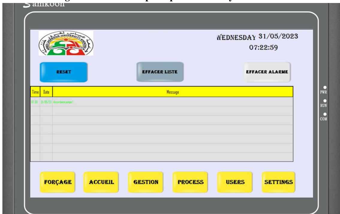
Figure III.38 :La vue principale des alarmes
