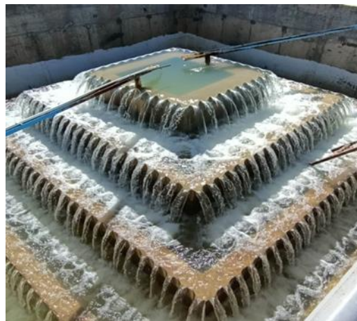
Figure III.11: cascade d'aération photo réaliste
