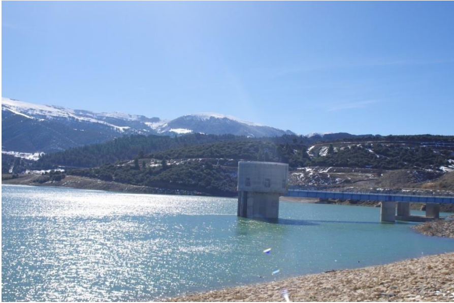
Photo N°06 : Barrage de Tagharist (source CFK.2015).
