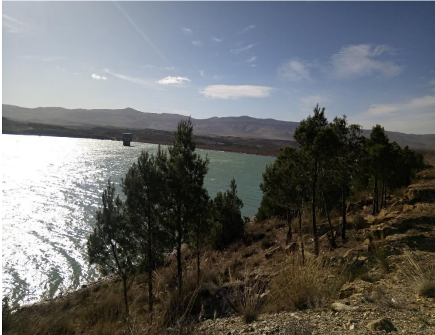
Photo N°01 : Barrage de Babar (source :photo prise par Boumaaza.N,2020)
