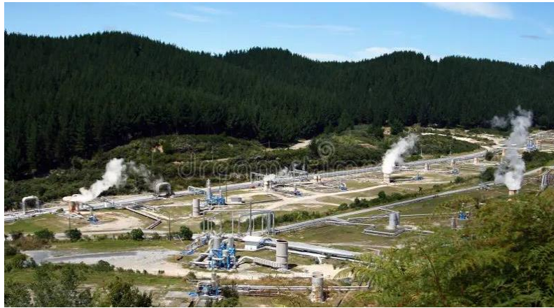
Figure 4 Centrale de Wairakei, en Nouvelle-Zélande. 1958 (Engineering New Zealand, 2008)
