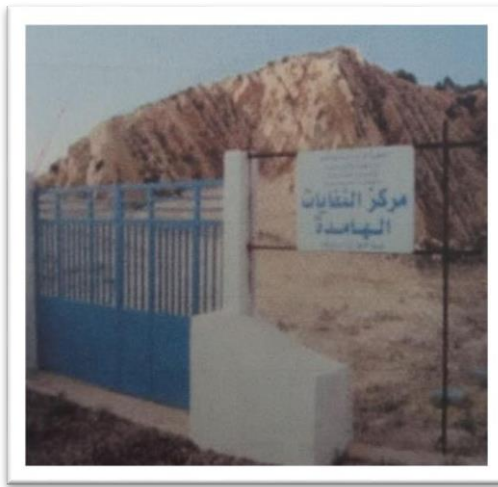
Figure 25 : Centre des déchets inertes
