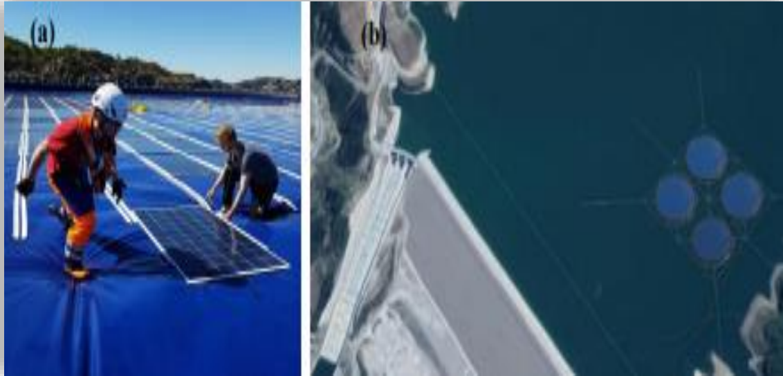
Figure I.5 : Système PV avec quatre îlots circulaires. (a) Il a une résistance mécanique. (b) Îlots circulaires de 500 kWc. [10]
