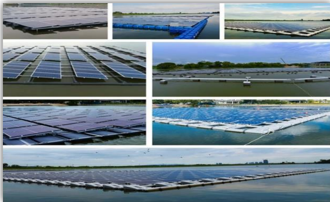
Figure I.16 : Types de flotteurs et aménagements installés dans la zone d'essai (SERIS) [26]
