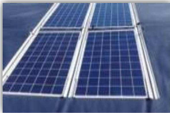
Figure I.4 : Modules implantés sur une membrane non perméable conçue pour résister aux contraintes mécaniques et à l'exposition au soleil.
