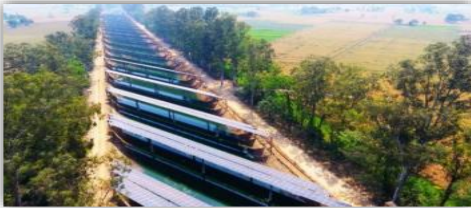
Figure I.6 : Système photovoltaïque flottant sur canal d'irrigation
