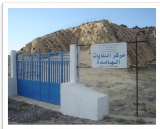
Figure (12) : Centre des déchets inertes
