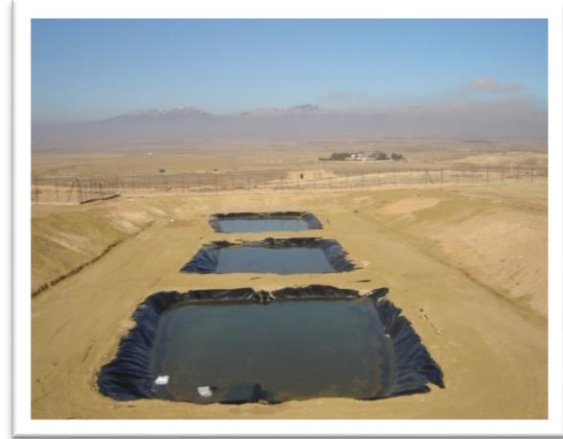
Figure (11) : Bassin de Décantation
