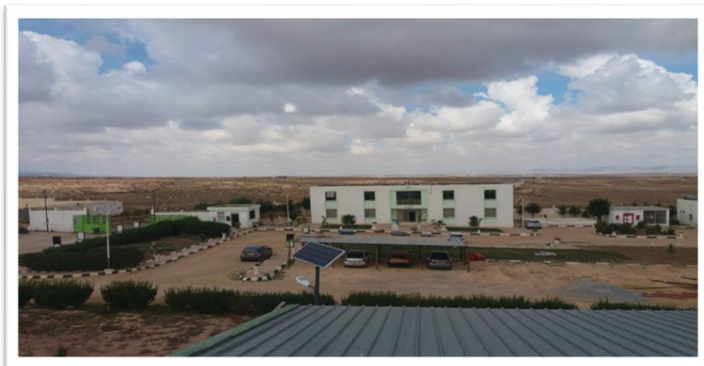
Figure (10) : Centre d'enfouissement technique des déchets de Baghai Wilaya de Khenchela.
