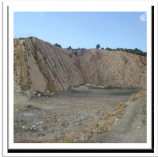
Figure (14) : Casier d'enfouissement des Déchets inertes
