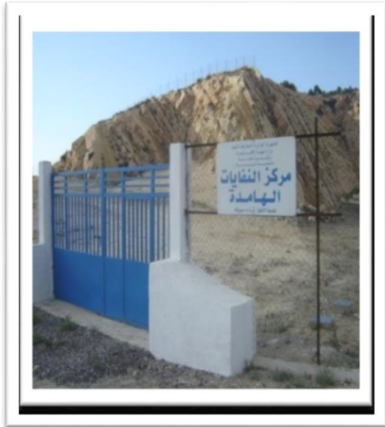
Figure (13) : Centre des déchets inertes
