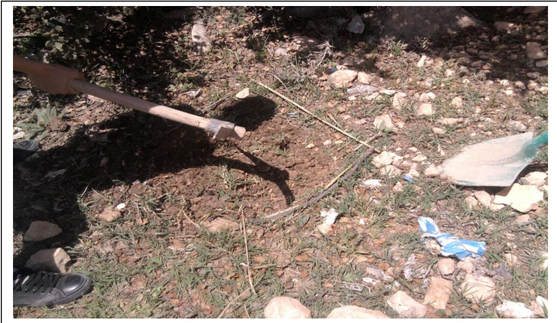
Figure -12 Préparation de la fosse
