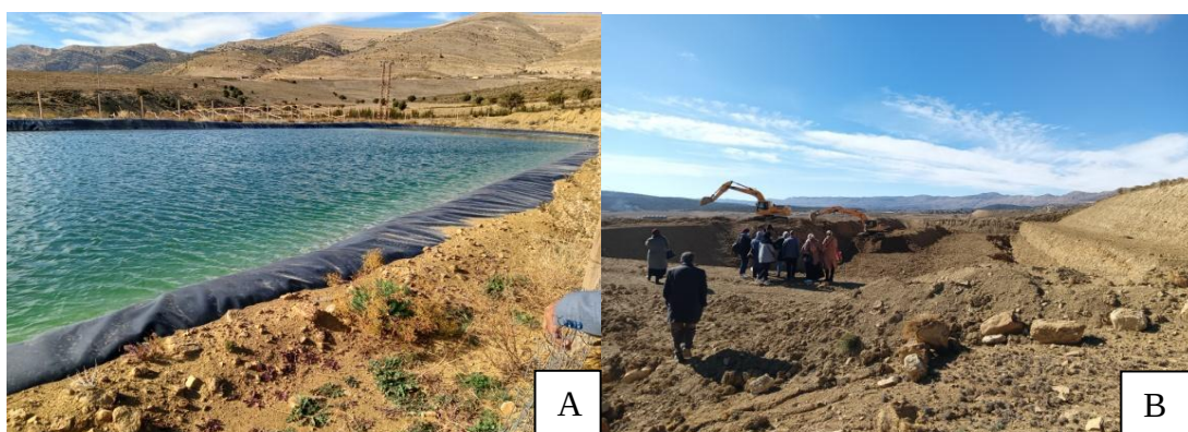
Figure 12 : (A) L'un des géomembranes de la coopérative, (B) Géomembrane en cours de préparation ( Photos originales, 2023 ).
