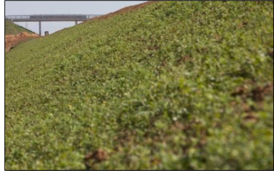
Photo 12 : Merlon de terre végétalisée
