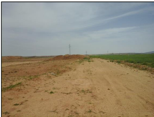
Photo 3: Déblai et remblai et dégradation du paysage
