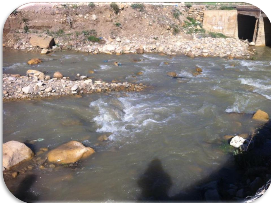
Figure n° 27 : photo représente l'aval de la digue.
