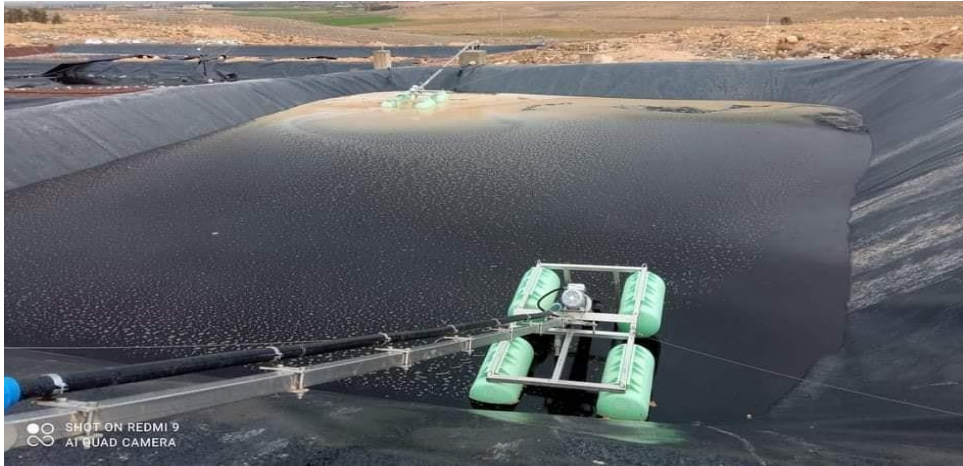
Figure 17: Drainage de lixiviat vers les bassins de décantation.
