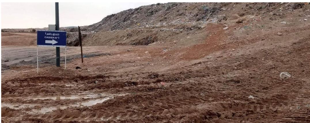
Figure 14: Recouvrement réalisé sur 95% du casier n°01.
