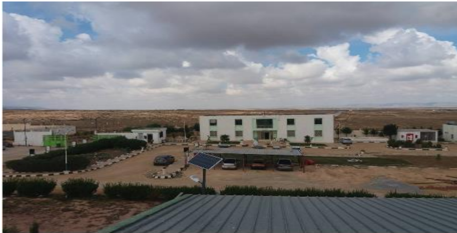
Figure 1: Photographie représentant da décharge sanitaire de Baghai (Khenchela).
