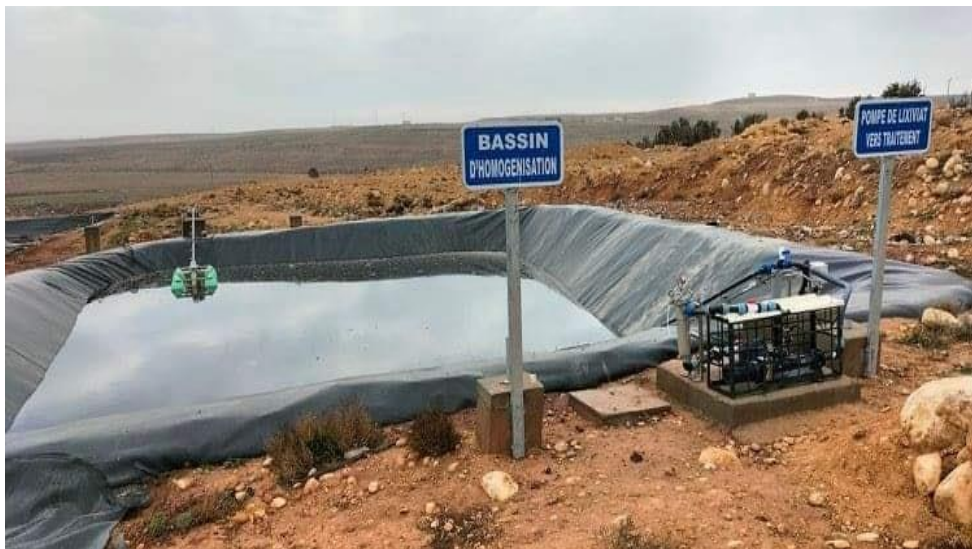
Figure 18: Bassin d'homogénéisation du lixiviat et pompe vers le centre de traitement.
