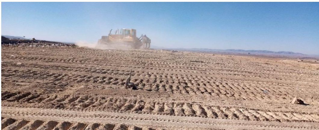
Figure 13: Opération de recouvrement de la tranchée n°01.
