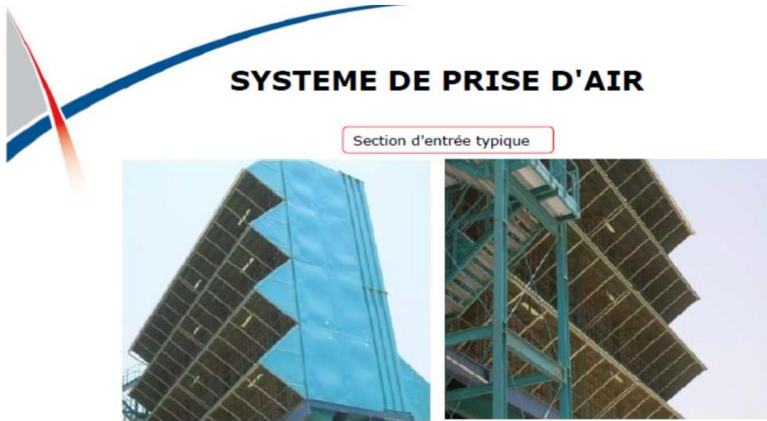
Figure II-10 : système de prise d'air
