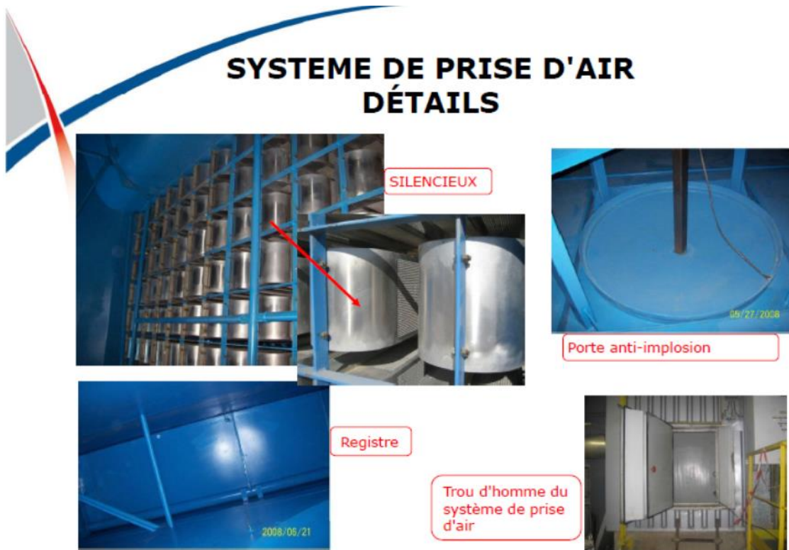
Figure II-10 : système de prise d'air
