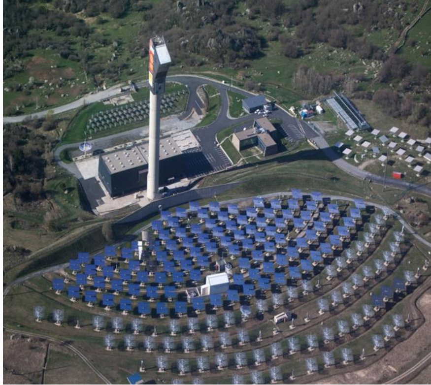
Figure I-3 : Centrales solaire de THERMIS.
