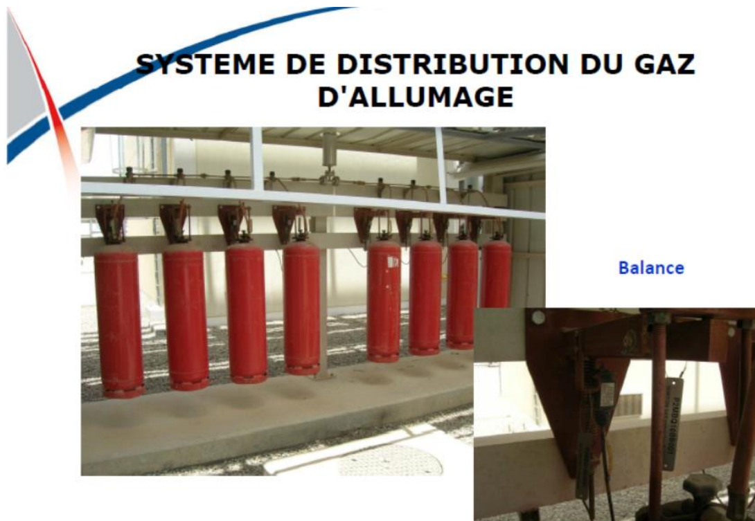
Figure II-22 : Système d'allumage à gaz.
