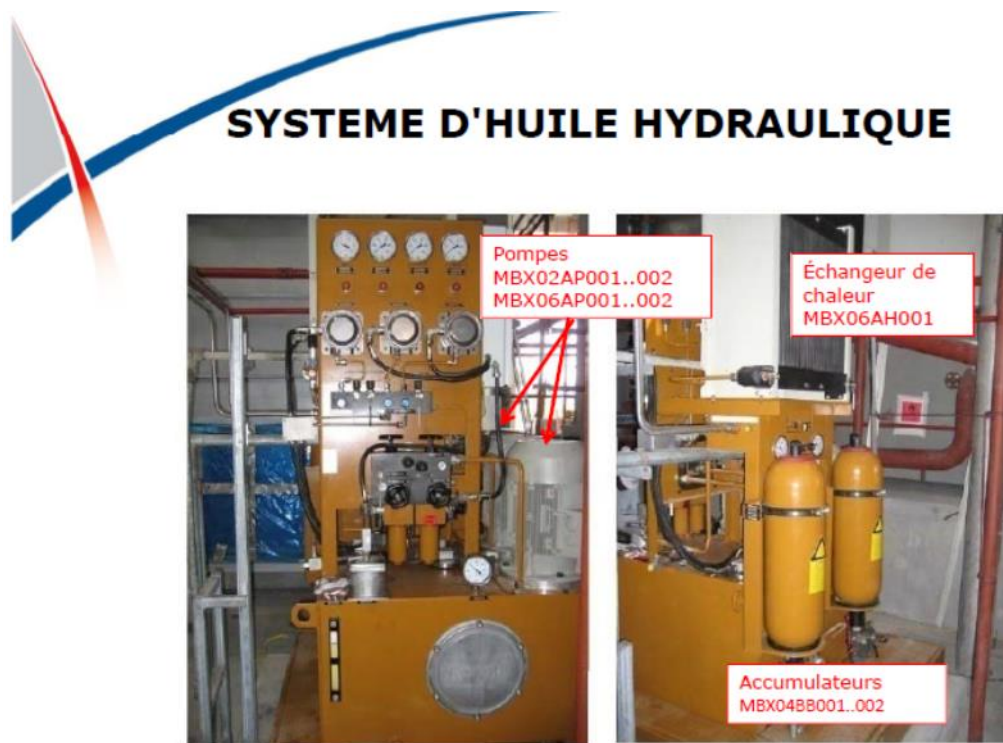
Figure II-20 : Système d'huile hydraulique.
