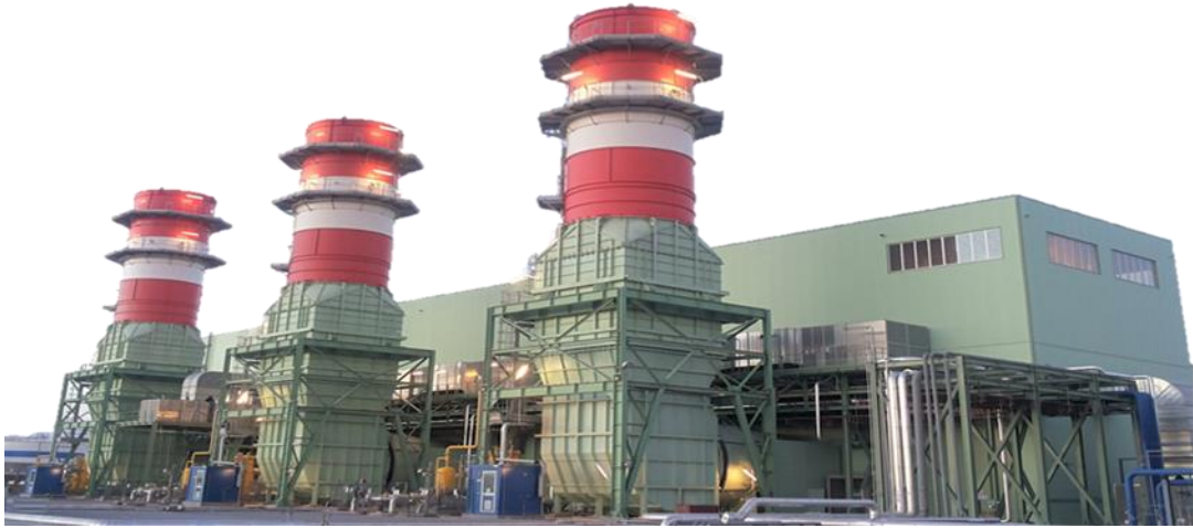
Figure II-5 : Centrale turbines à Gaz V94.2 de «LABREG » (3X 140.5MW)
