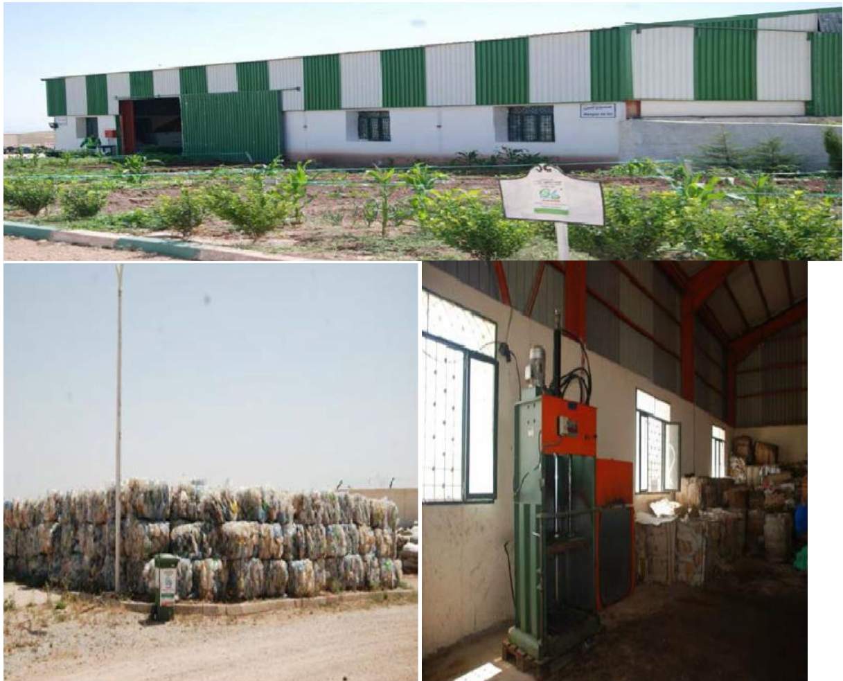
Figure : 11- Stockage d'emballage du plastique et carton
