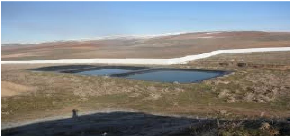
Figure : 16 - Bassin de lixiviats du CET de Khenchela
