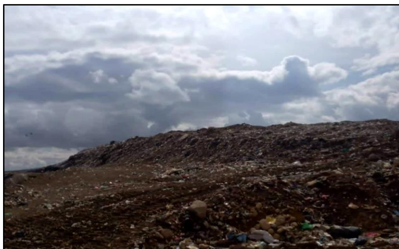
Figure 54 : Le casier d'enfouissement en exploitation, (CET, 2022).
