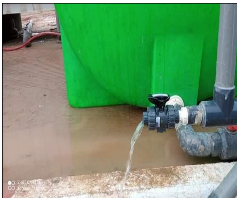
Figure 71 : L'eau épurée (perméat), (CET, 2022).
