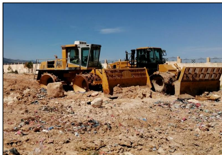
Figure 59 : Recouvrement des déchets, (CET, 2022).
