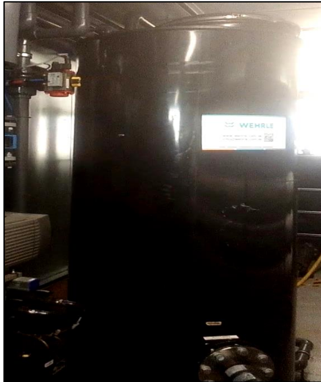
Figure 66 : Filtre à sable, (CET 2022).
