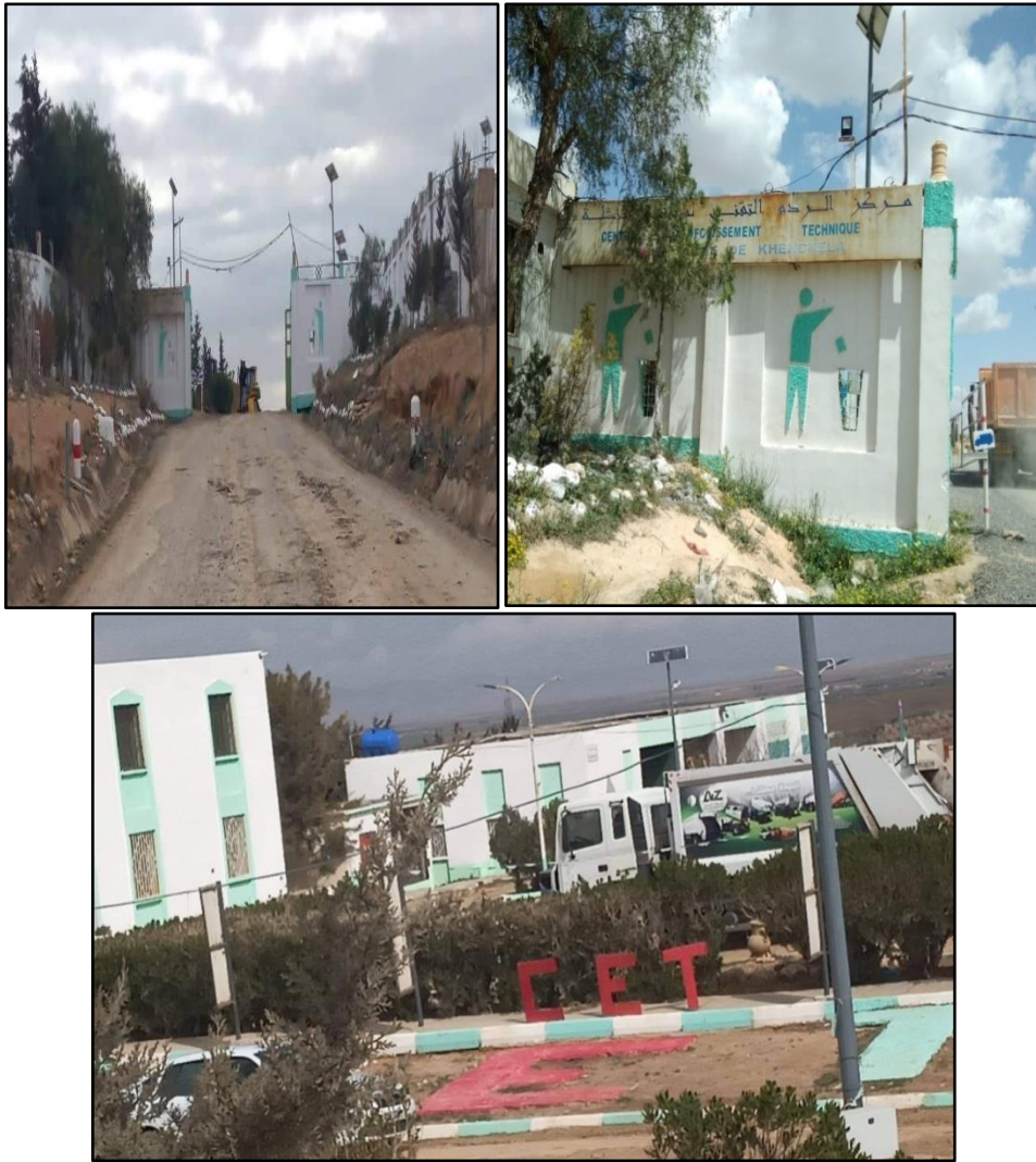
Figure 24 : Centre d'enfouissement technique de Baghaï, (CET, 2022).
