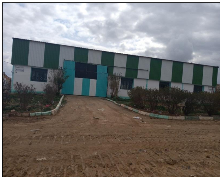
Figure 35 : Aire de récupération et de tri (Hangar), (CET, 2022).
