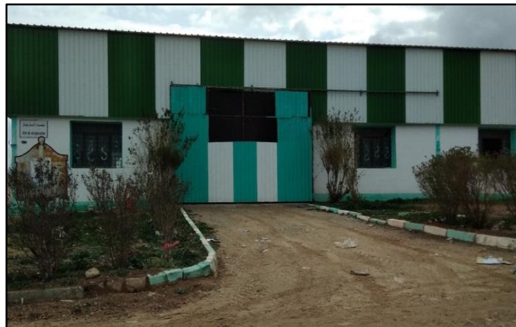
Figure 26 : Hangar de tri des déchets solide, (CET, 2022).
