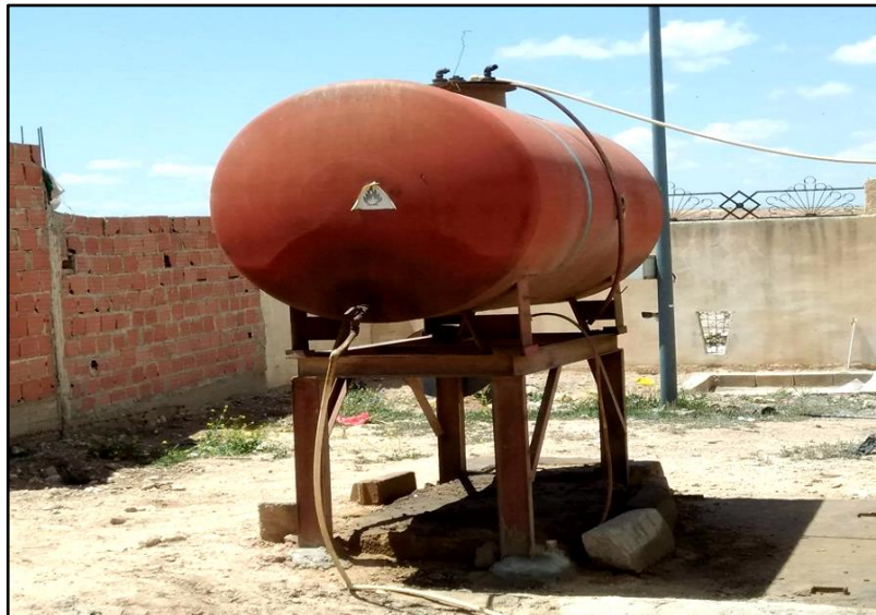
Figure 46 : Réa au gasoil, (CET 2022).
