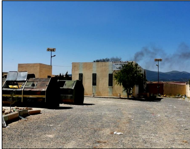
Figure 41 : Centre d'incinération des DAS, (CET, 2022).
