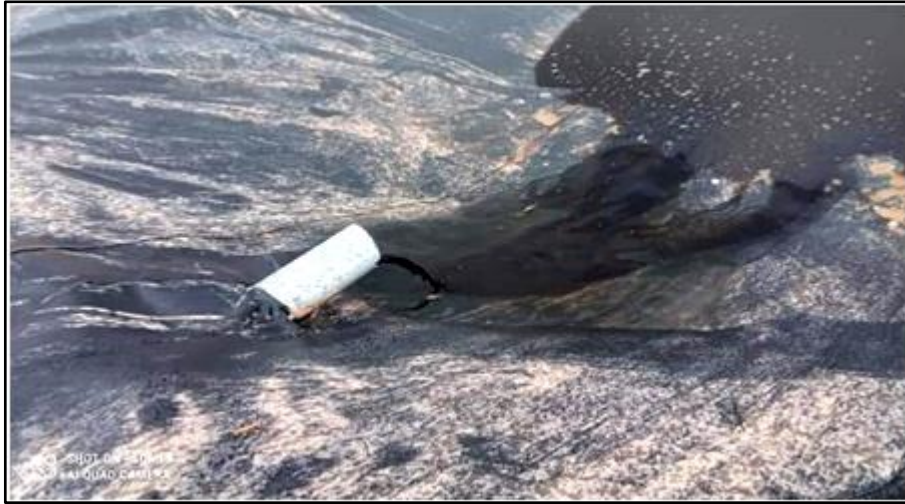
Figure 61 : Bassin du lixiviat, (CET, 2022).
