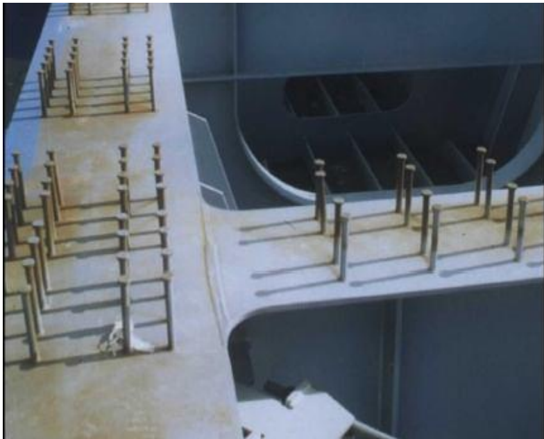
Figure VIII.9 : Connecteurs de type goujons
