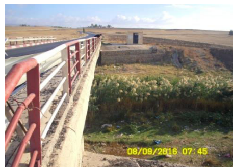
Figure 8 : Station 2 A l'amont du barrage de foug elkhanga (Oued Sedrata).
