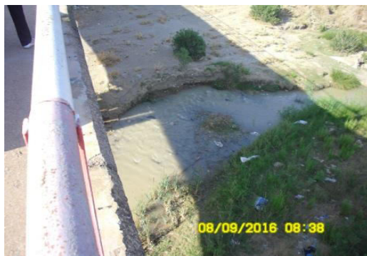
Figure 9 : Station 3: A l'aval du Barrage de foug elkhanga.
