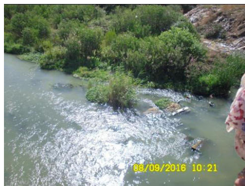
Figure 11 : Station 5 : A l'aval du barrage de Bouhamdane.
