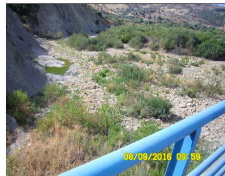
Figure 10 : Station 4 : A l'amont du barrage de Bouhamdane.
