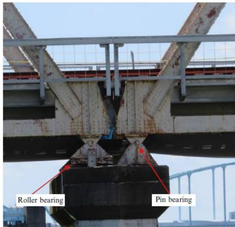
Figure 32 :Roulement à rouleaux et roulement à broches. (Photo de Lin.)
