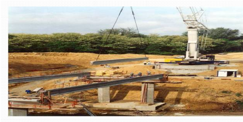
Figure 29 : La manœuvre de la pose des poutre sur le pont.
