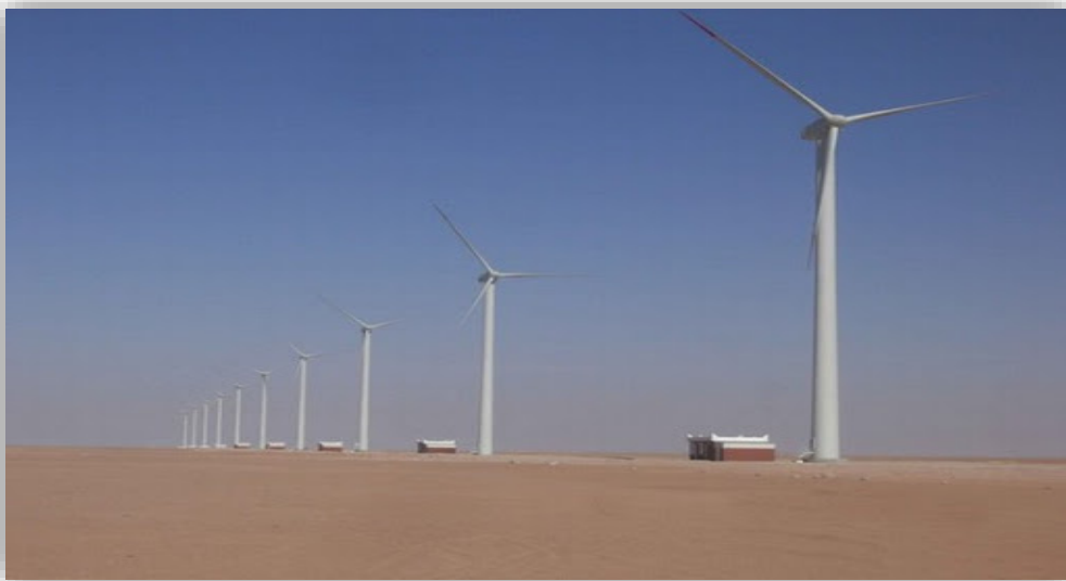
Figure 8: Wind farm (Kabertene Adrar)
