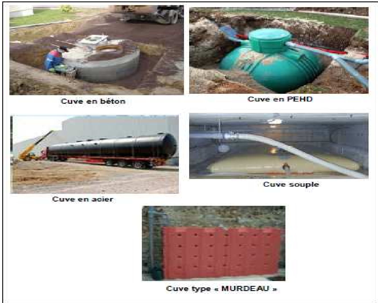
Figure n°16: Différents types de cuves de stockage de l'eau de pluie.
