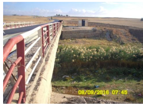
Figure 10. Station 2 A l'amont du barrage de foug elkhanga (Oued Sedrata).
