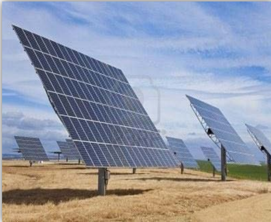
Figure III.1. Mise en place d'un panneau solaire carré
