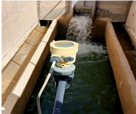
Figure III.15: Les filtres à sable photo
