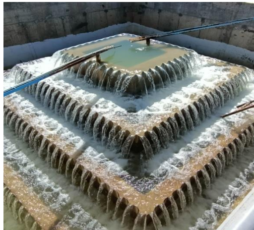
Figure III.11: cascade d'aération photo réaliste
