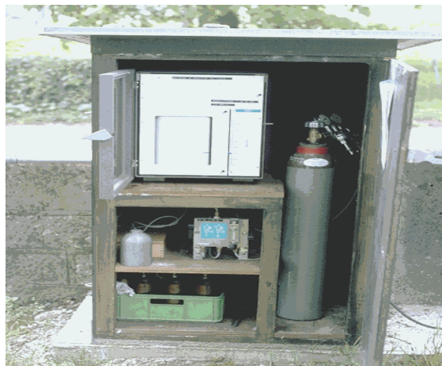
Figure.32: Le limnigraphe à pression ou "bulle à bulle"
