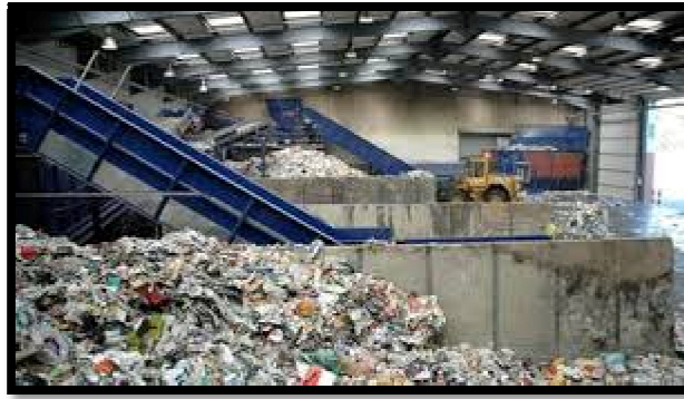
Figure III.8 : Centre de tri CET Khenchela
