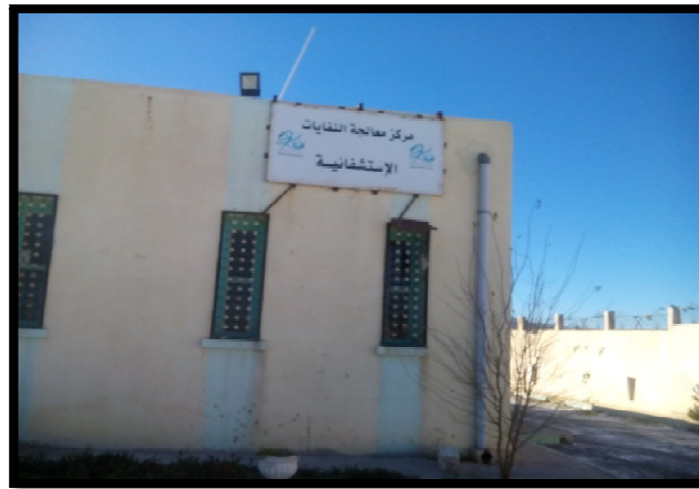
Figure III.9 : Centre de traitement des DASRI
