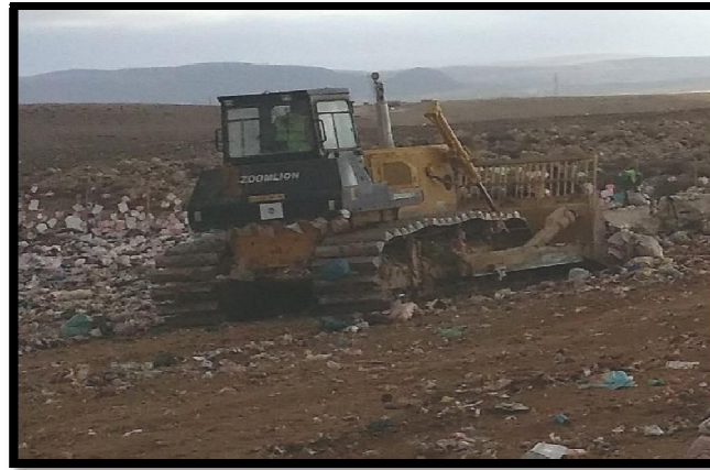
Figure III.20: Déchets déversés et assemblés dans des alvéoles
