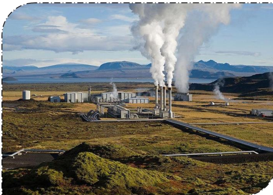
Figure I-7 : Centrale géothermique de Nesjavellir en Islande pour la production électrique.
