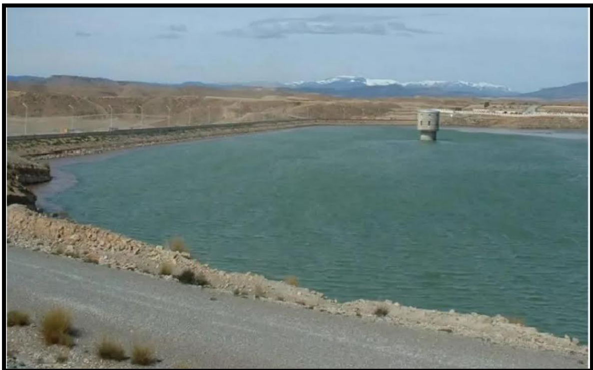
Photographie 02. Vue générale de barrage de Babar, wilaya de Khenchela.
