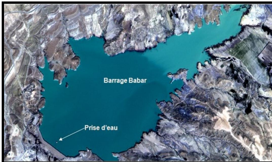
Figure 12. Image satellite du barrage de Babar.
