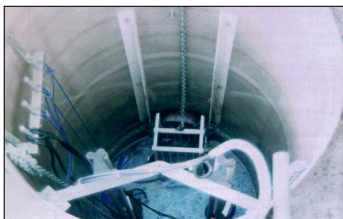
Fig. 1.2 : Photographie d'un ouvrage de relevage.
