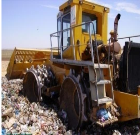
Figure 16. Compactage des déchets
