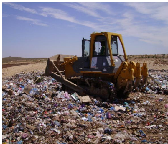
Figure 15. Déchets déversés et assemblés dans des alvéoles
