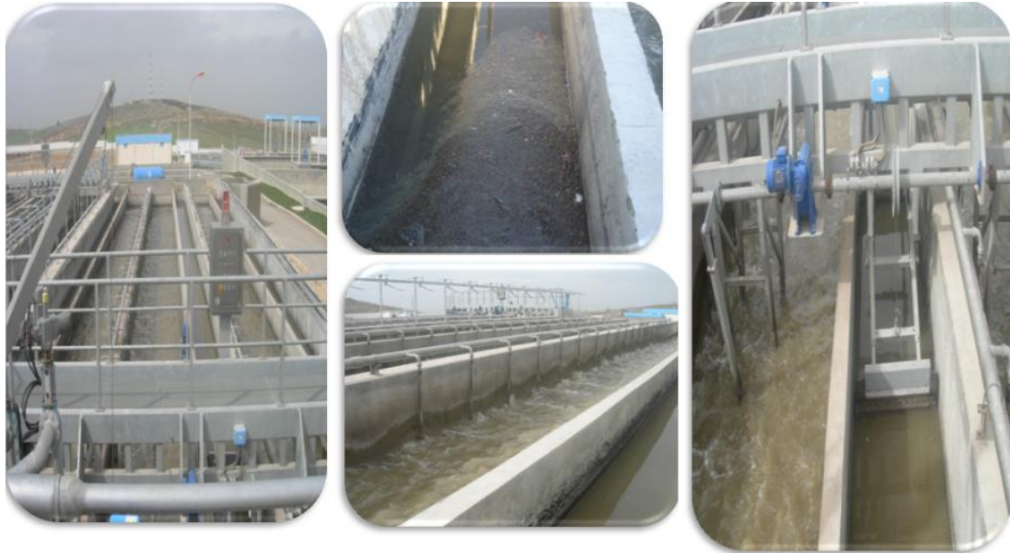
Figure n° 26 : Le dessablage et déshuilage (STEP Khenchela)
