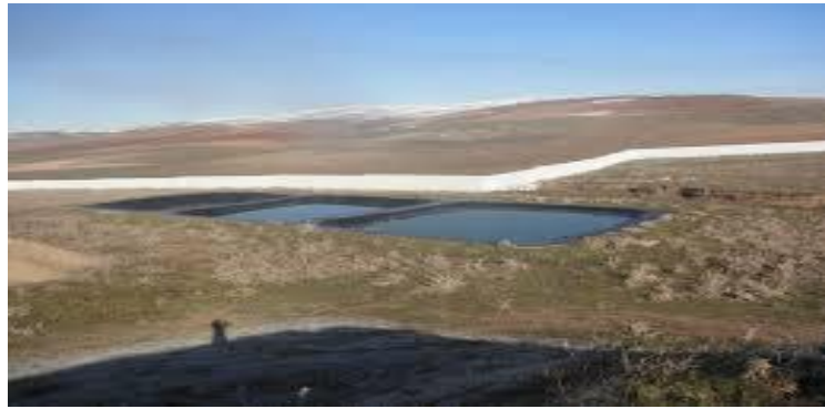
Figure n° 32 : Bassin de lixiviats du CET de khenchela
