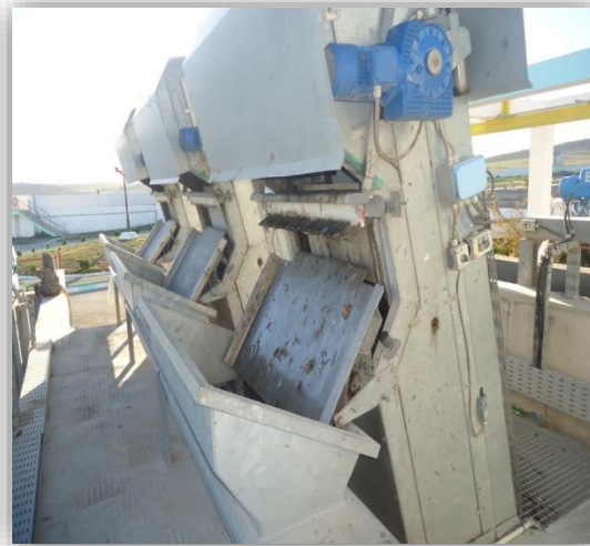
Figure n° 25 : La grille fin (STEP Khenchela)
