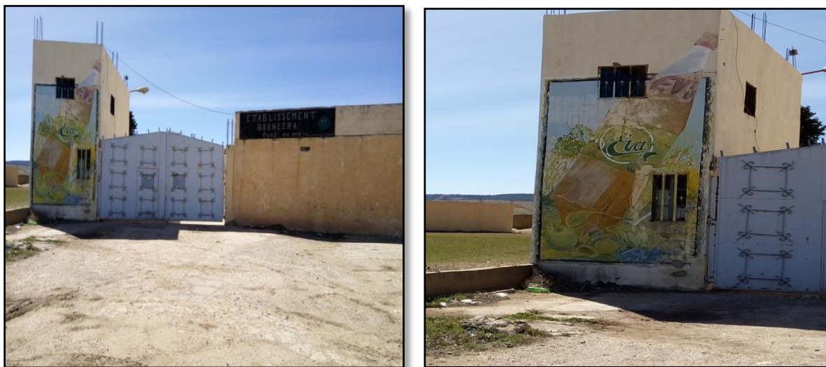
Photo.07: Usine de boisson (2018)
