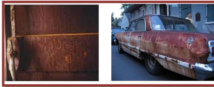
Fig. (I.4): Corrosion généralisée : exemple d'une porte et d'un véhicule corrodés.
