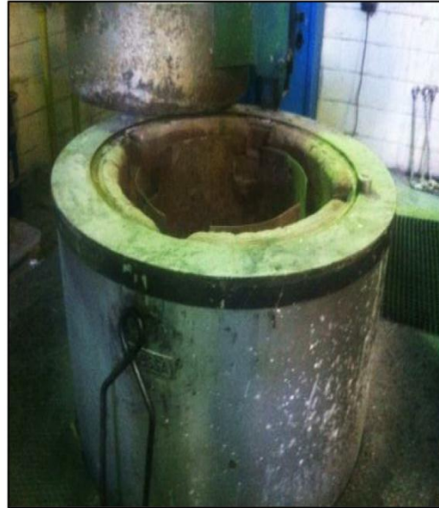
Figure IV.11. Four à cuve de préchauffe
