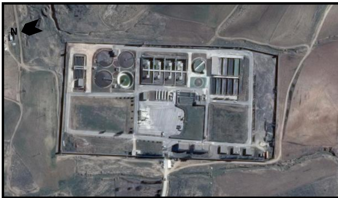
Fig.04 : Aperçu générale de la station de Khenchela (Google Earth).
