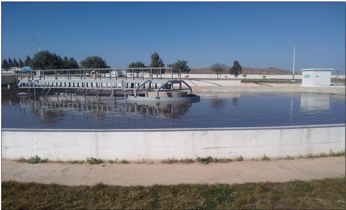
Fig.09 : Le bassin de clarification de la station de Khenchela.
