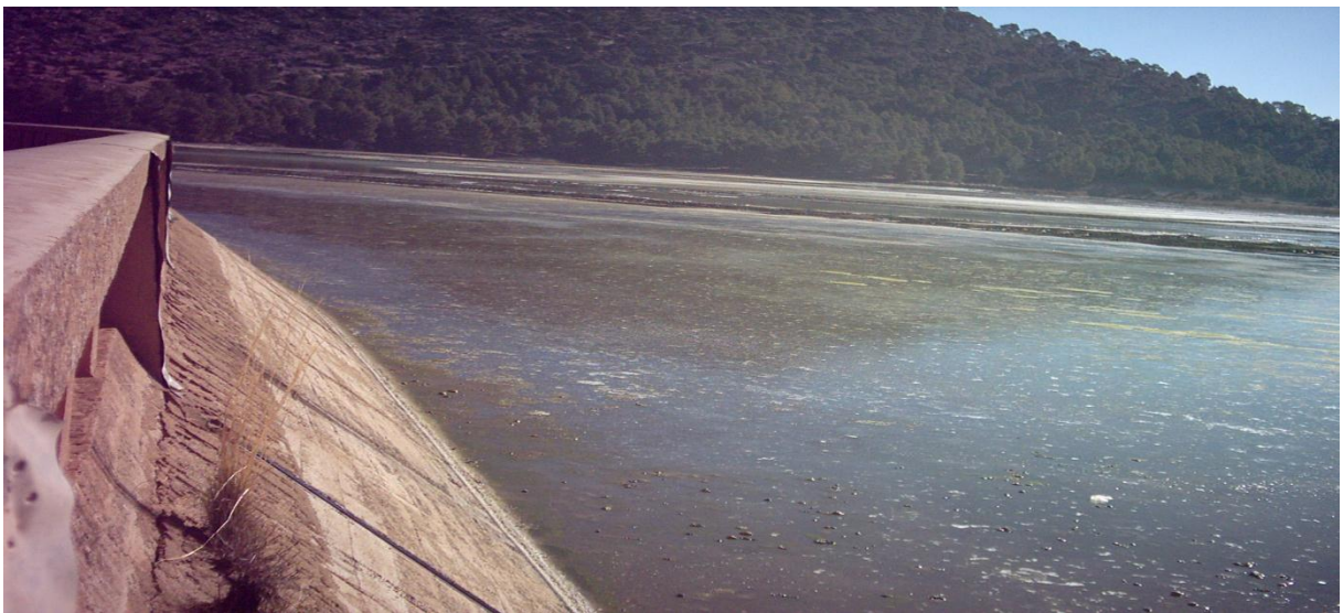
Fig.n° 43 : Envasement du barrage de Foug El Gueiss.
