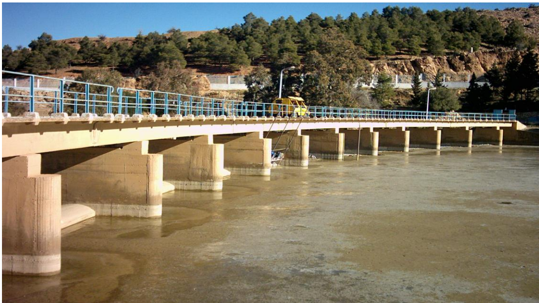
Fig. n° 04: Barrage de Foum El Gueiss.
