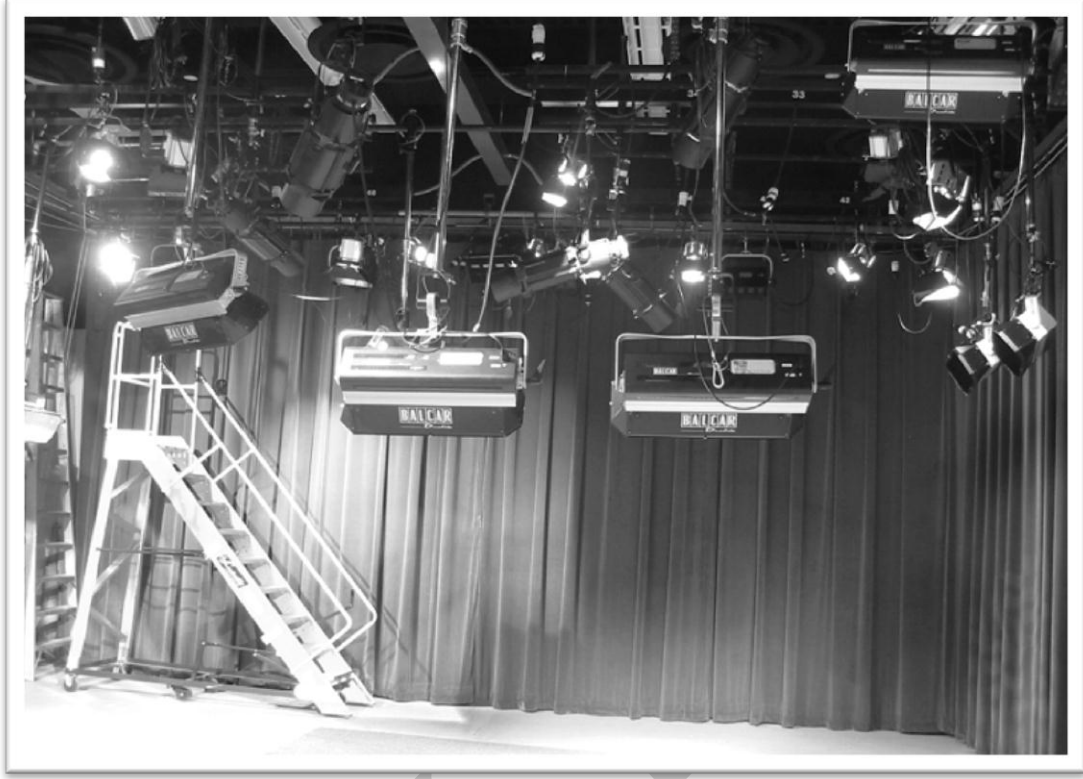
صورة رقم (12): توضح شبكة الإضاءة داخل استوديو التصوير التلفزيوني*
