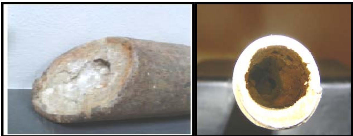
Figure III.6 : Dépôt de Sulfate de Strontium ( \text{SrSO}_4 ) une conduite
