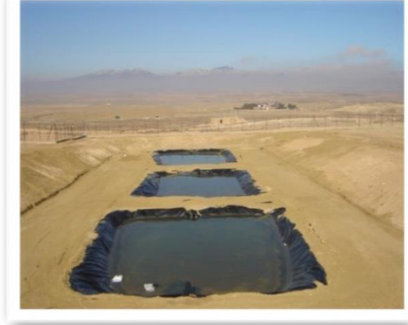
Figure 10 : Bassin de décantation des déchets ménagers
