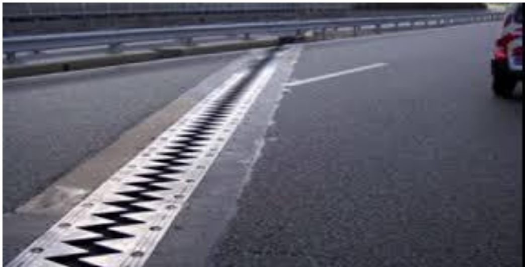
Figure II-4 Photo réelle d'un joint de chaussée.
