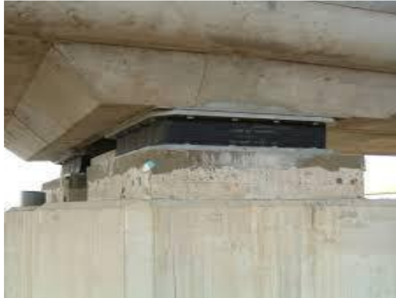
Figure II-2 : photo d'un Appareil d'appuis.
