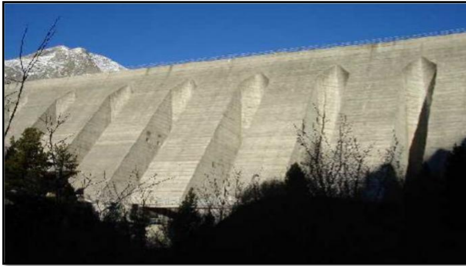
Figure02 : Barrage poids à contreforts de Plan d'Amont (Aussois)
